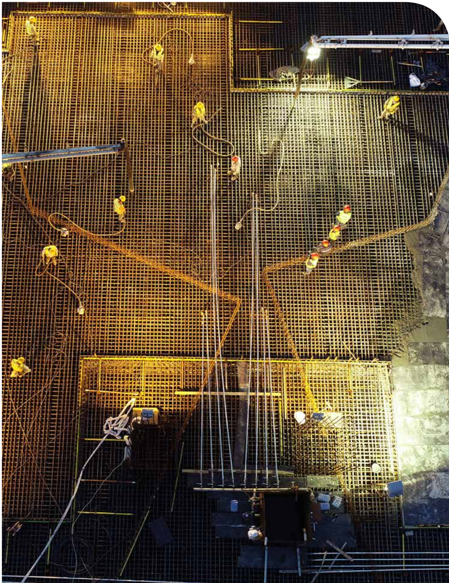
/// Фото: Новица Антић - Овако је све почело, постављање арматуре темеља термоелектране „Костолац Б3“
